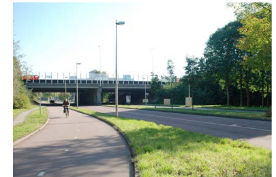
↑ De bestaande onderdoorgang ter hoogte van de Archimedeslaan, gezien vanaf Rijnsweerd.
