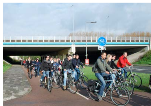
↑ Dagelijks passeren 40.000 fietsers de onderdoorgang naar de Uithof.
