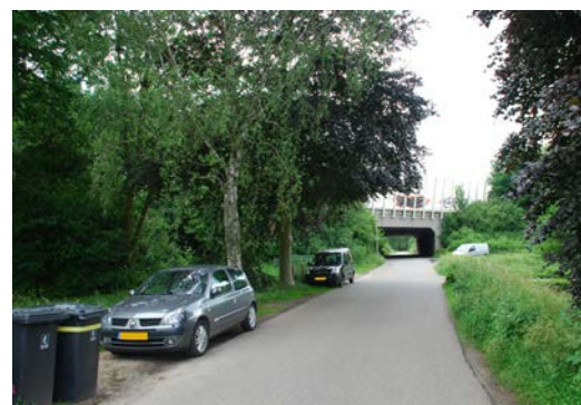
↑ De bestaande onderdoorgang Voordorpsedijk, gezien vanuit Voordorp.
