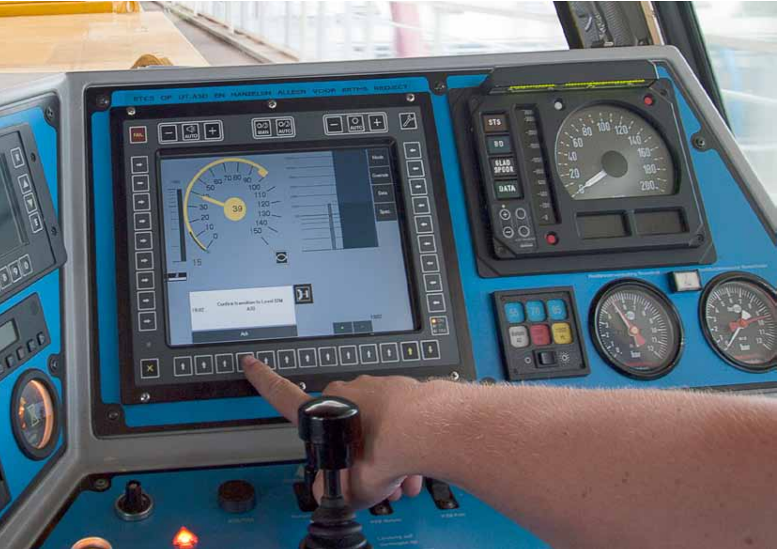
Op de DMI (Driver-Machine-Interface) in de cabine van de machinist is o.a. te zien hoe hard de trein rijdt en hoe hard de trein op die locatie mag rijden. (Foto: ProRail)
