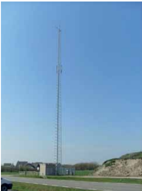
Figuur 3.28 C2000 mast (voorbeeld)
