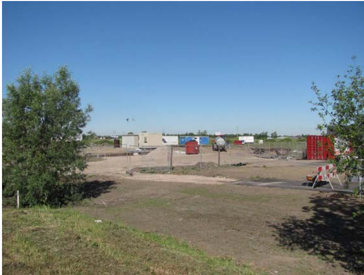
Figuur 2 Bouwwerkzaamheden in plot A32
