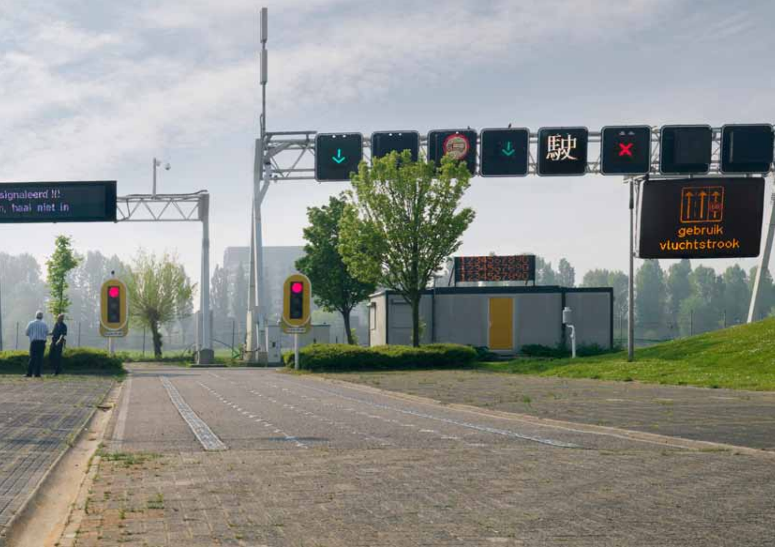
Rijkswaterstaat test de systemen om het verkeer in goede banen te leiden.
