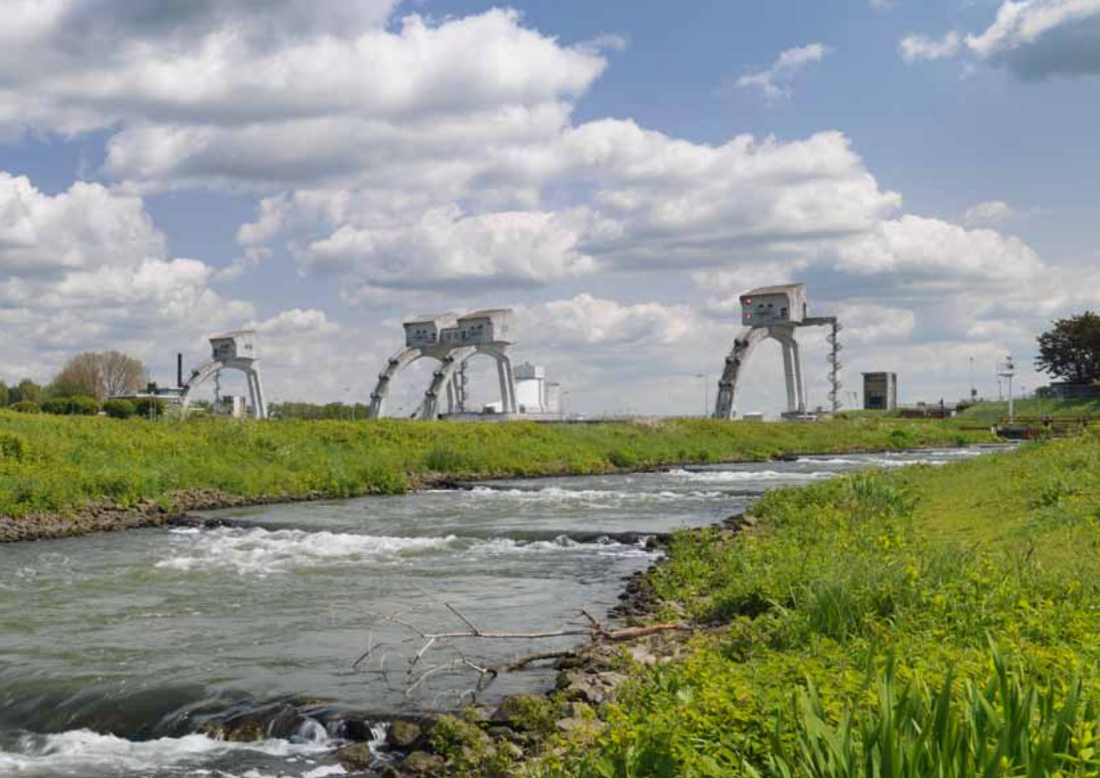
Stuw Hagestein met een vispassage in de Nederrijn.
