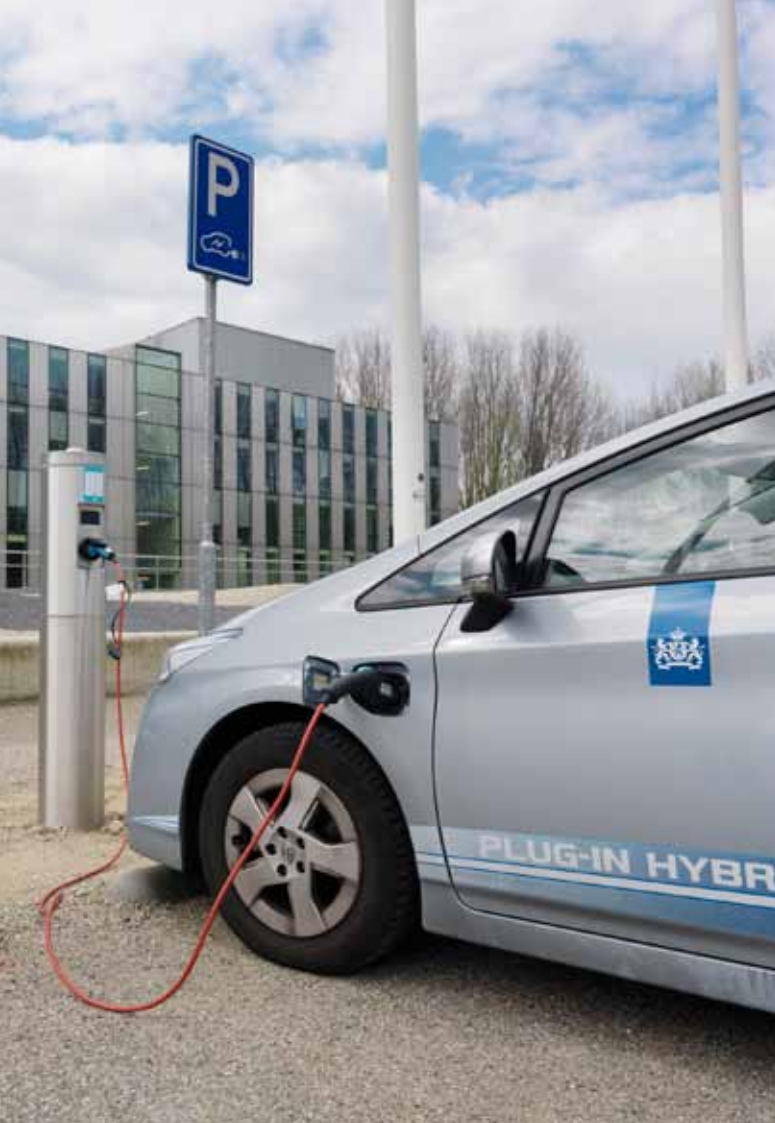
Oplaadpunt voor elektrische auto's bij een kantoorpand van Rijkswaterstaat.
