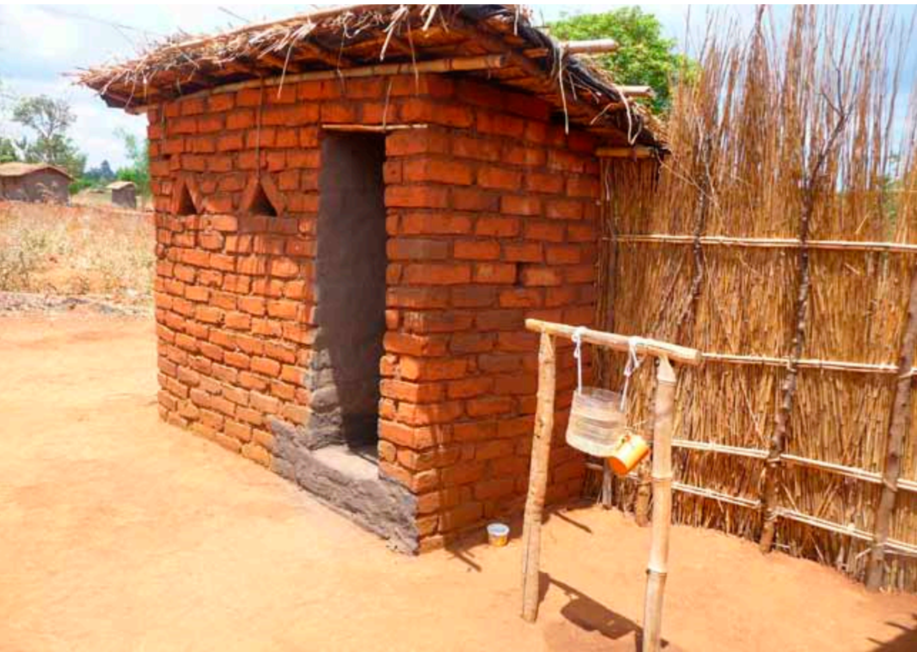
Latrine met mogelijkheid om handen te wassen in Mozambique
