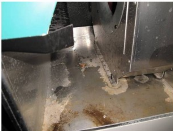
Figuur 19 (links): Voorbeeld van inwendige vervuiling (schimmel) in een ventilatie-unit met een kunststof behuizing.
