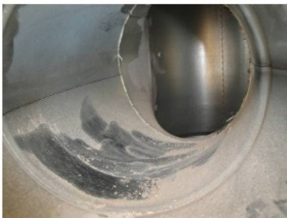
Figuur 18 (rechts): Voorbeeld van een luchttoevoerkanaal dat vervuild is door stof.
