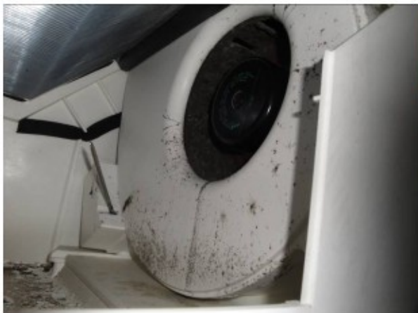
Figuur 19 (links): Voorbeeld van inwendige vervuiling (schimmel) in een ventilatie-unit met een kunststof behuizing.
