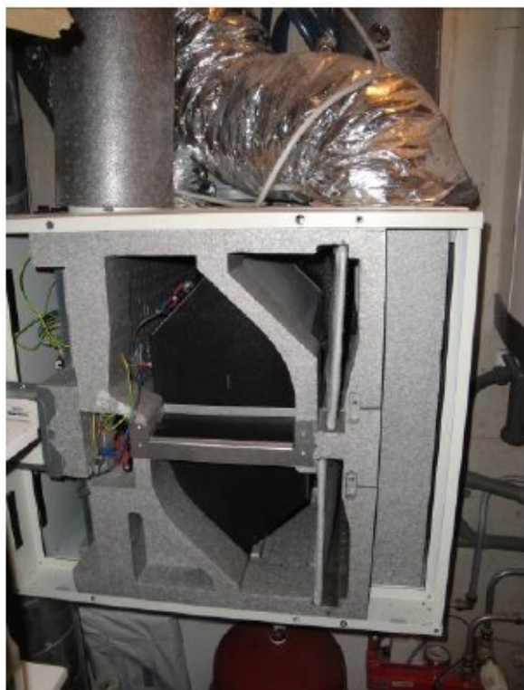
Figuur 21: Het inwendige van een ventilatie-unit met balansventilatie. Duidelijk zichtbaar zijn de zeshoekige warmtewisselaar met daarvoor de bypass (ruimte in de unit waardoor lucht langs de warmtewisselaar kan stromen).
