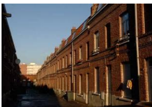
Te renoveren woningen in Quartier Ouest , Roubaix
