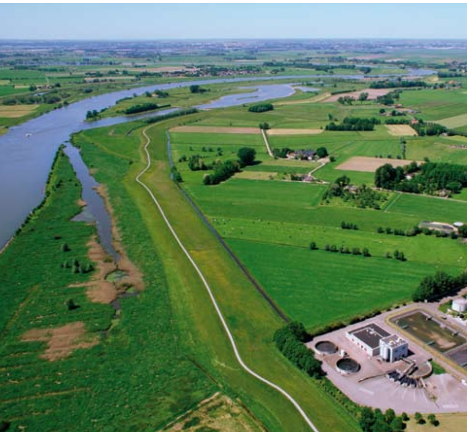
Oude situatie dijkverlegging Westenholte
