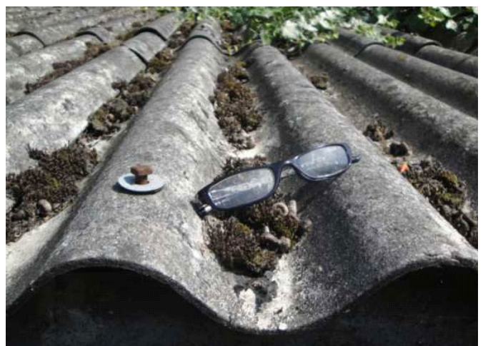
Figuur 5-1: Een golfplaten dak van asbestcement in Lisse.
