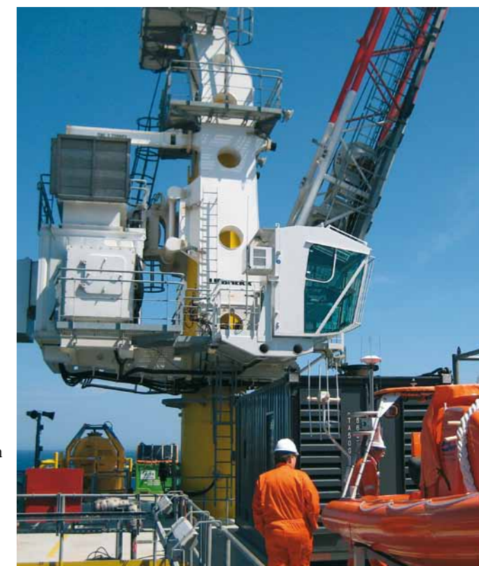
Offshore kraan met vakwerkgekiek (Foto: SodM)
