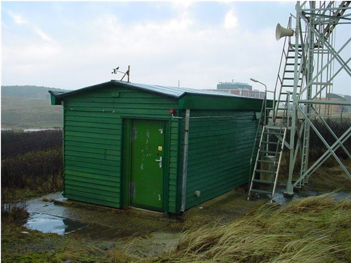
Locatie Nieuwe radarmast Petten.
