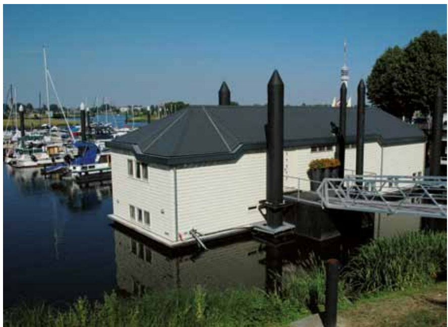
Foto boven: Zolang de loopbrug niet te steil is, is deze woning wel rolstoeltoegankelijk, door een dynamisch met de waterstand op en neer gaande loopbrug. Foto: ABC Arkenbouw.
