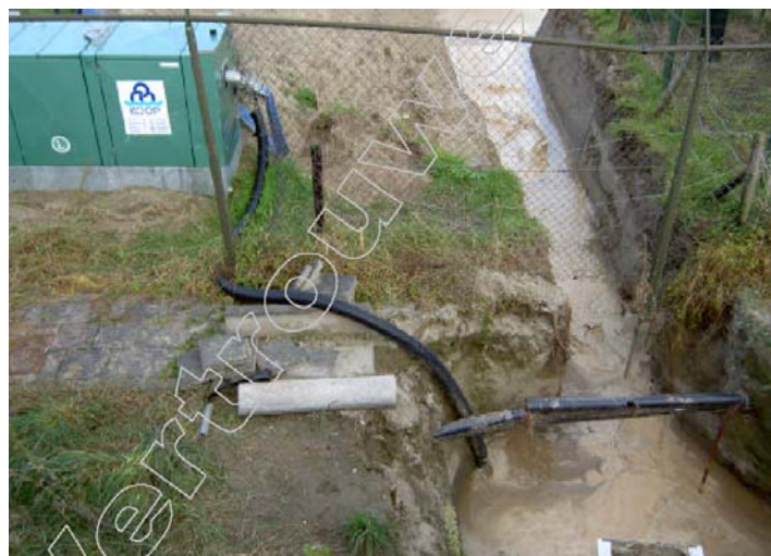
Foto 5-5 Pompset, geplaatst bovenop liggende leidingen (ref. 1-r)
