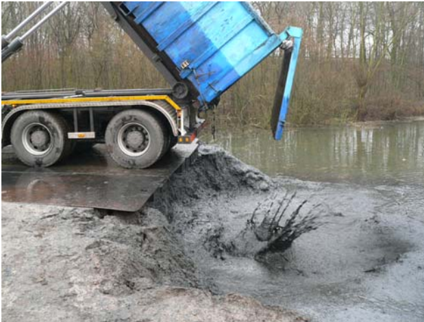
Figuur 3.5 Toepassen van baggerslib in een voormalige zandwinput.
