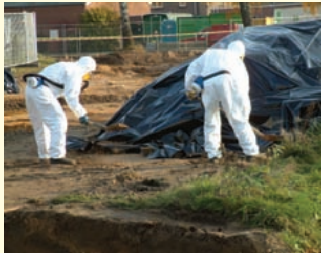
Asbestsanering in 2004 (foto: bewoners Zwanenstraat, Goor)
