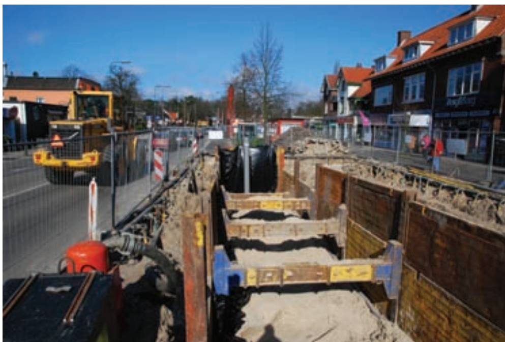
Bodemsanering voormalig benzinstation Bilthoven – ontgraving met gestempelde grondkerende constructie
