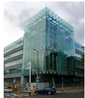
page 46, 47, 57 Korte Voorhout 7 Den Haag Built in 1975 Architect: Jo Vegter and Mart Bolten Renovated 2006-2008 Architect: Meyer en Van Schooten Architecten
