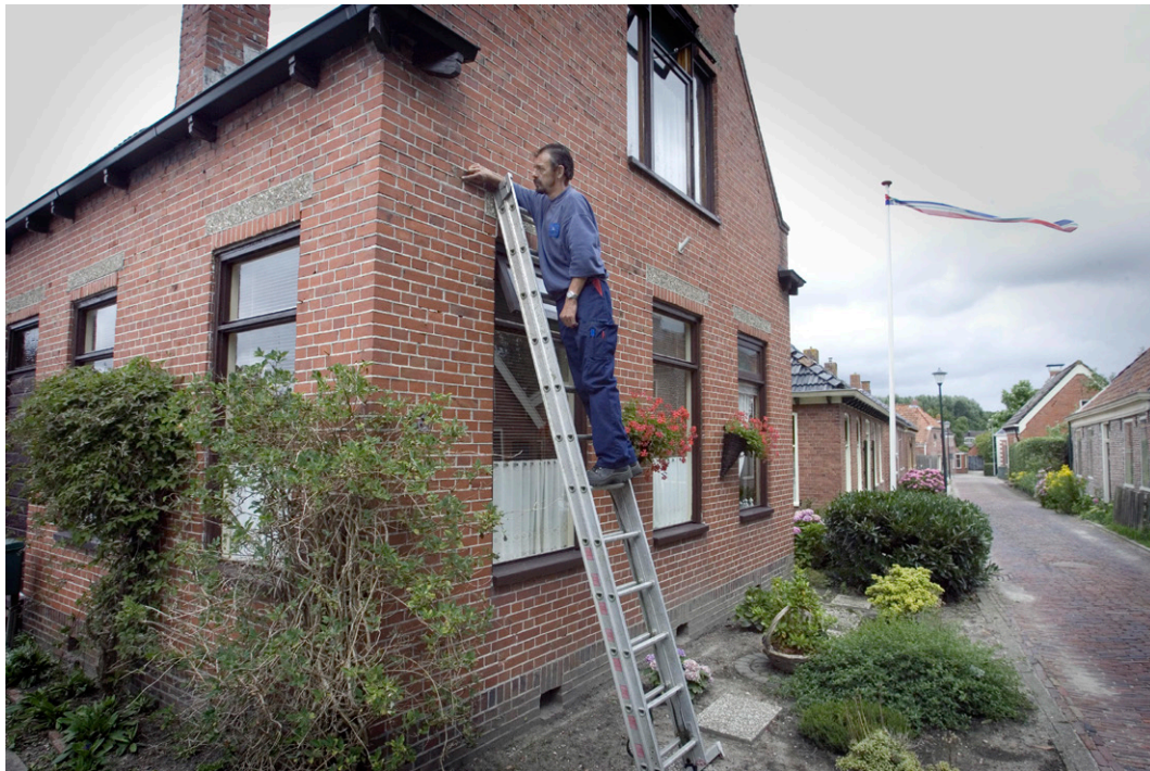
Bewoner wijst scheuren aan die zijn ontstaan door een aardbeving met een kracht van 3,5 op de schaal van Richter. (ANP / Dennis F. Beek)
